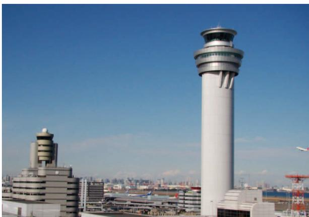
▲左側が旧管制塔（77.6m）、右側が完成した新管制塔（115.7m、世界第3位）。管制室は多層ゴムを用いた免震構造。セキュリティも万全。（写真撮影者 田村真紀夫）
