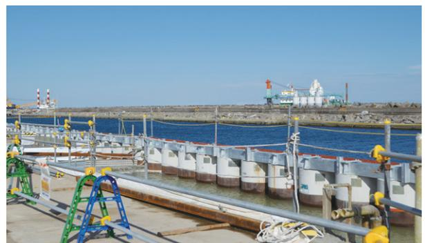
海に流れる汚染水を減らすため、昨年設置された海側遮水壁。1号機から4号機の護岸近くに、長さ30メートルの筒状の鋼を、全長780メートルにわたり、埋め込んだ。遮水壁の内側と外側で、水の色が違った。
