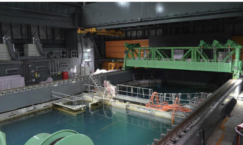
4号機の使用済み核燃料プール。2014年12月、1535体の使用済み核燃料の移送が完了した。福島事故当時、燃料が装てんされていなかったため、ほかの3基のような炉心損傷事故は起こらず、周囲の放射線量も比較的低い。
